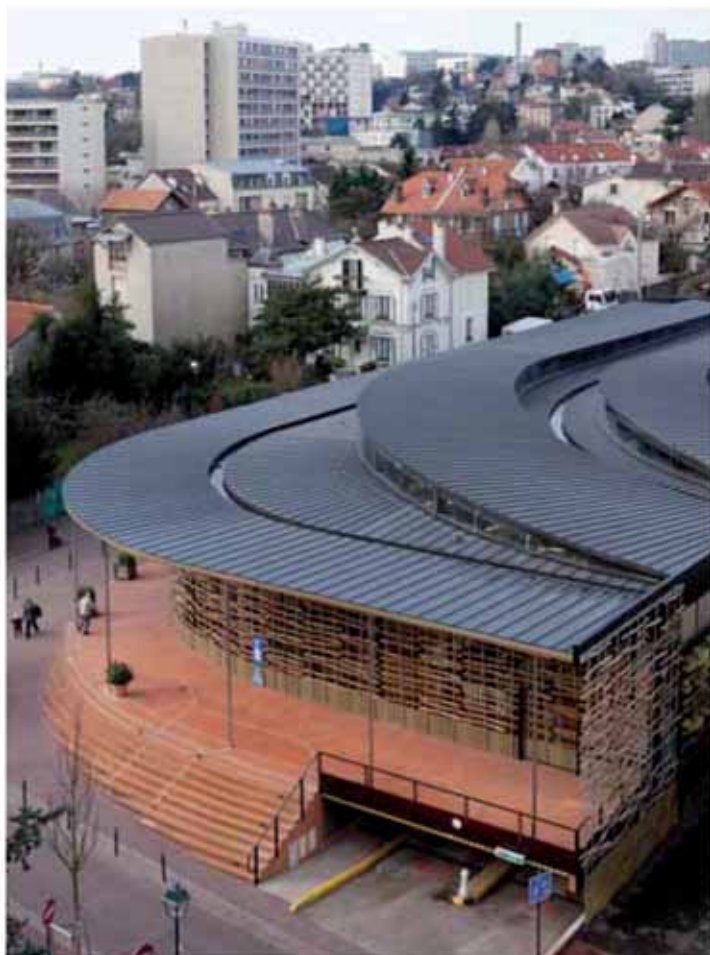
Halle de marché comestibles - Fontenay aux Roses - Francia - Architetti Bertheliet & Tribouillet
