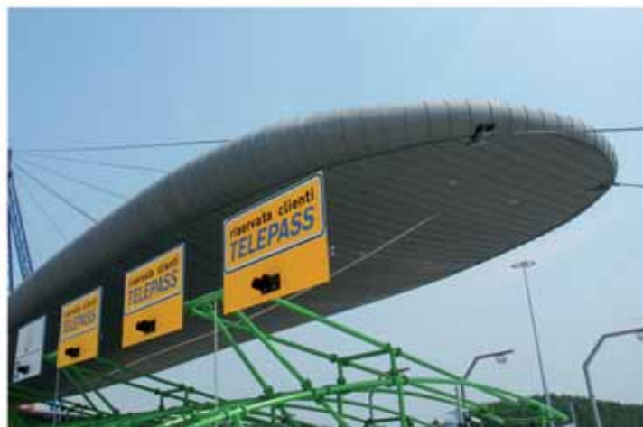
Casello Autostradale Di Ronchis - Latisana Ud - Italia - Architetto Giovanni Caprioglio
