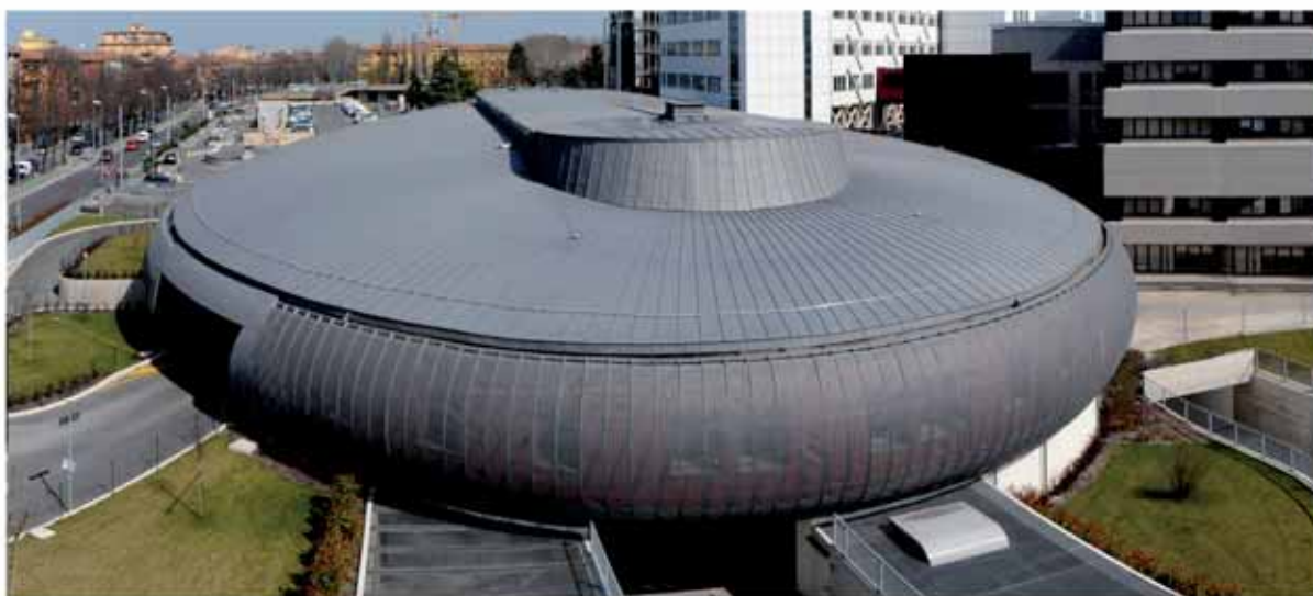
Pronto soccorso di Parma - Italia - RUP Ingegnere Andrea Sacconi - Installatore dello zinco Lattneria Gallina
