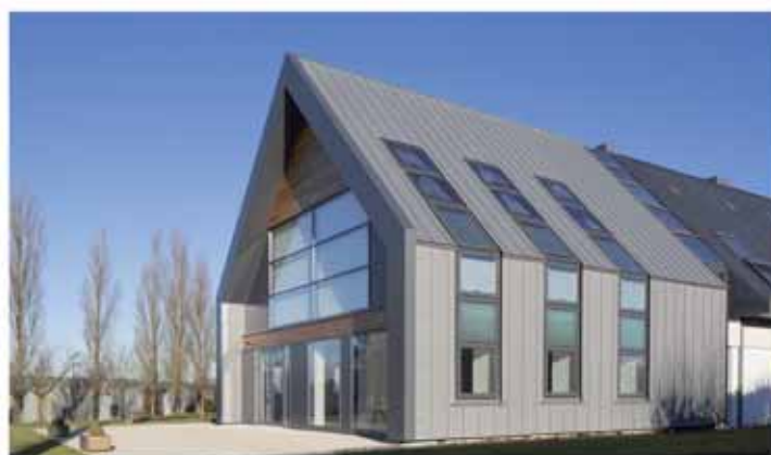
Edificio Amministrativo VKR France, Feuquières en Vimeu - Francia - Studio BTC
